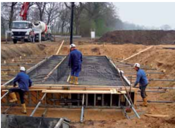
Betonieren der Fundamente
